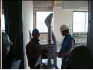
❖圖 4-8 說明: 3F排煙風管洩漏 測試作業
