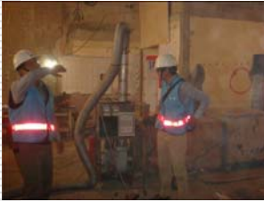
❖圖 4-7 說明: 1F排煙風管洩漏 測試作業
