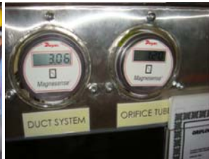
❖圖 4-10 說明: 現場測試數據顯示 管洩漏量
